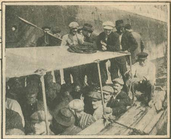
A bordo do rebocador que os conduziu a terra.
