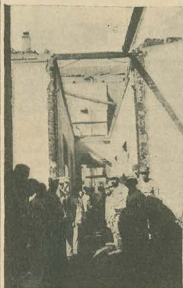
Interior do quartel do 6. Os escombros («Cliché» de André de Moura).
