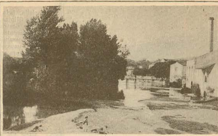
Um trecho tirado da ponte sobre o Nabão, e que faz lembrar «Bruger-la-morte», de Rodembach
