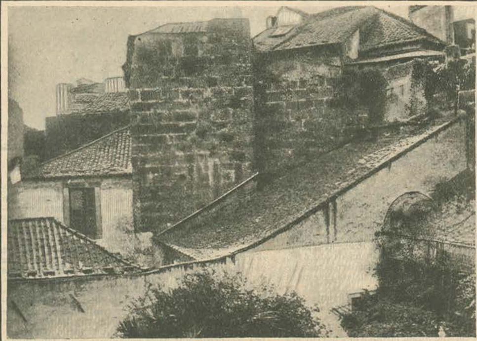
Torre e lanço de muralha da cerca moura nas trazeiras das casas da Rua do Infante D. Henrique.
