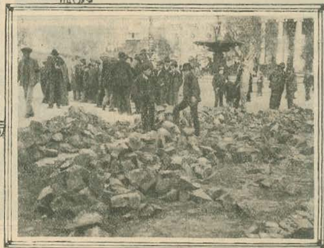
No Rocio. Material para uma barricada e para as obras que não terminara mais.
