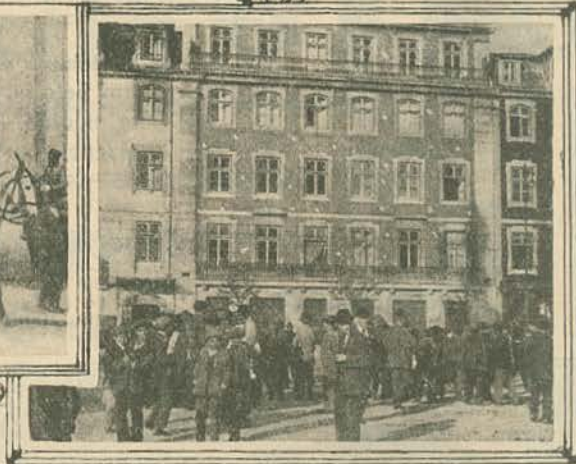
No Rocio. Vendo o predio Seixas completamente crivado de tiros de metralhadora. («Clichés» Serra Ribeiro).
