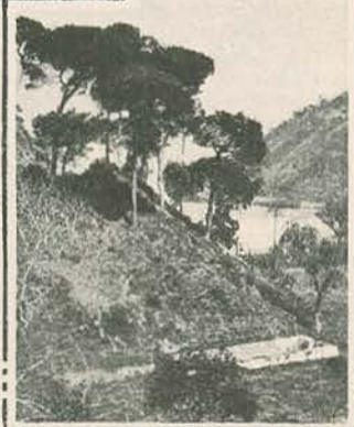
Trecho da Estrada de Penacova.—(Cliché de F. Pinharanda).
