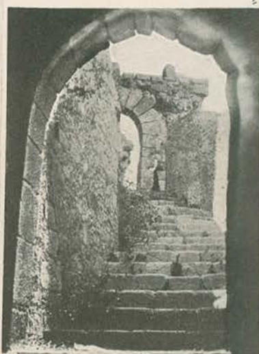
Porta setelrada e escada que dá para a galeria subterranea.
