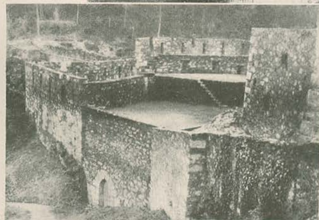
A muralha do lado sul, vista a cavaleiro, do interior.
