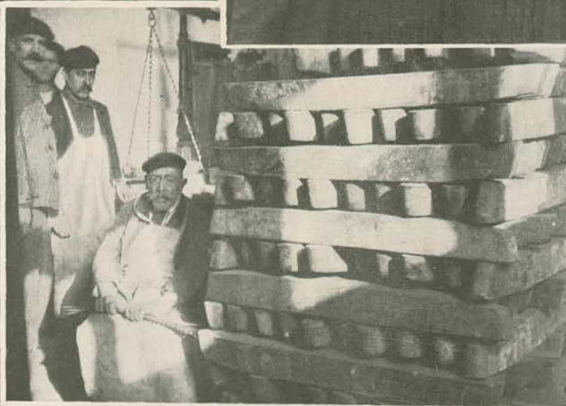
Casa da balança, na officina de fundição. Coluna formada por lingotes de cobre fino.
