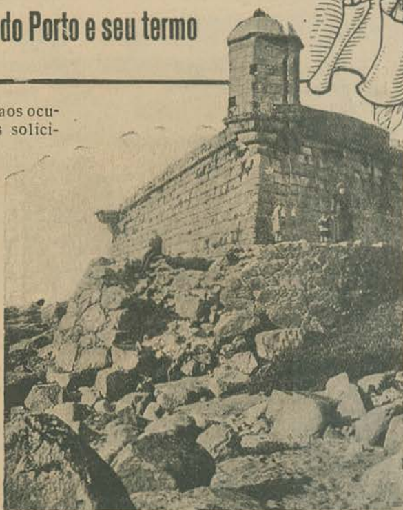
O CASTELO DO QUEIJO. — O revelim do bastião do lado sul e as ruínas do fosso.
