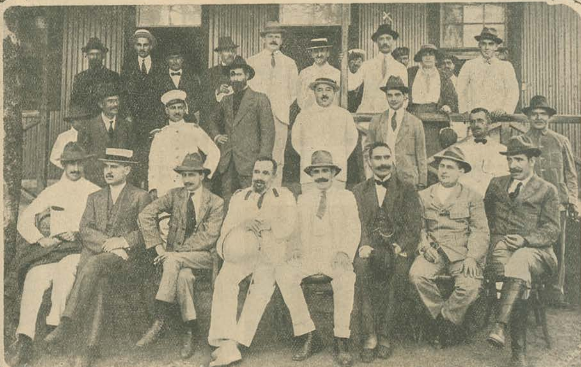
EM MARRACUENE. — Grupo de convidados que assistiram á inauguração da linha do caminho de ferro Lourenço Marques-Marracuene. Sobre o patamar do edificio da gare , o distinto engenheiro sr. Carlos de Sá Carneiro (X), diretor dos Caminhos de Ferro de Lourenço Marques.
