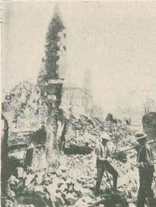
Uma comovedora reliquia do vandalismo germanico. Soldados ingleses removendo os escombros d'uma igreja de Cambrai, em busca de objetos sagrados.
