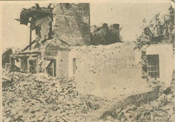
Um trecho das ruínas d'uma povoação situada n'uma das margens do Piava, reciprocamente de posse dos austriacos e italianos, que tem sido muito sacrificada pelas lutas de artilharia.
