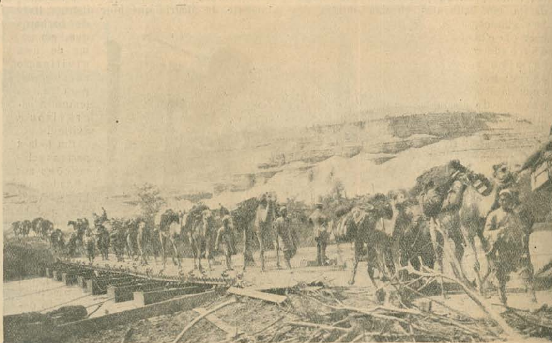
NA PALESTINA:—Um comboio de viveres e munições composto de camelos dirigindo-se ás primeiras linhas atravessa uma ponte que a engenharia improvisára.
