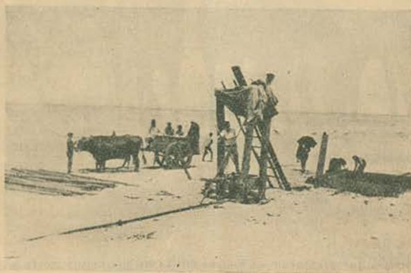
Um poço d'agua doce na praia e bomba para alimentação das caldeiras.—(Clichés da Fotografia Ramos, de Aveiro).
