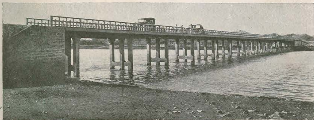
1, 2 e 3. Aspétos da grandiosa ponte, em cimento armado, da estrada de Lourenço Marques a Goba, construida sob a direção do ilustre engenheiro sr. Sá Carneiro.
