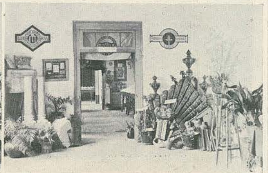
Instalação de produtos industriais dos srs. Ernesto Korrodi e Quiterio Korrodi
