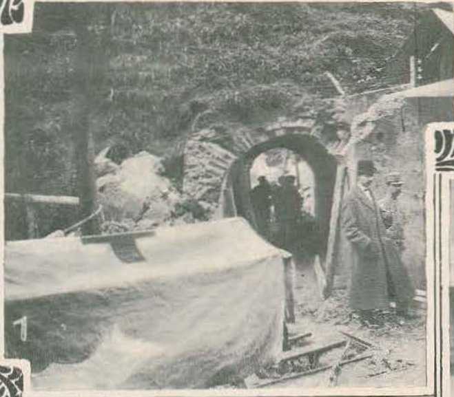
1—Um aspeto do pavilhão destruído.
