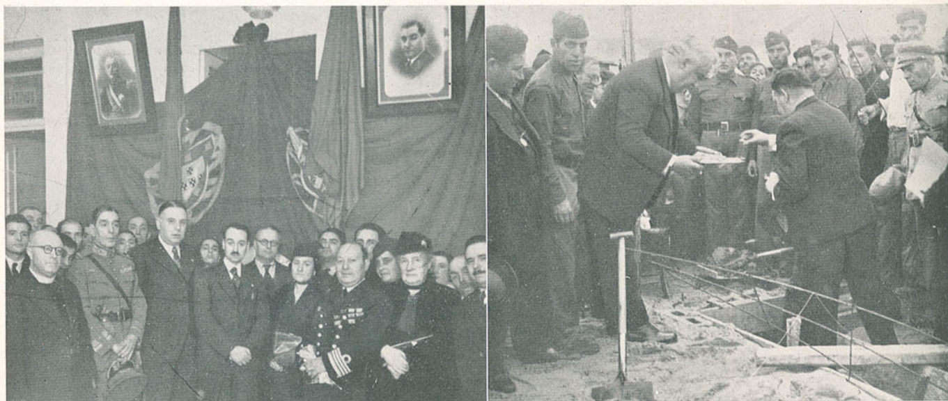
Um trecho da assistência, depois de descerrados os retratos do Chefe do Estado e do Presidente do Conselho no posto dentário inaugurado na Junta de Freguesia do Bonfim, no Pôrto. — A' direita : O sr. governador civil de Setúbal lançando a primeira pedra do bairro novo na Caparica.
