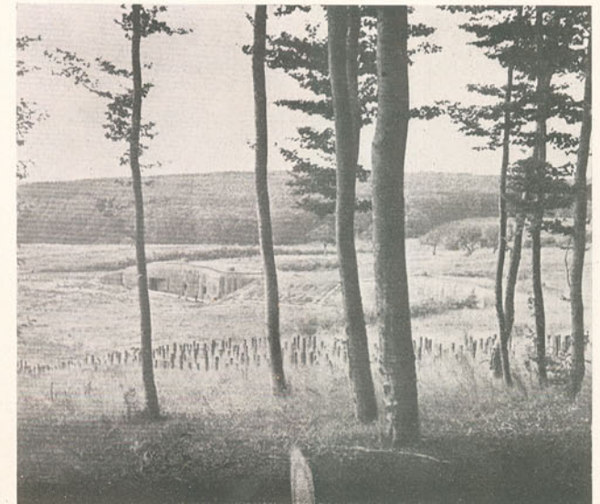
A linha Maginot mostrando os tacos de rails que inutilizaram os tanks
