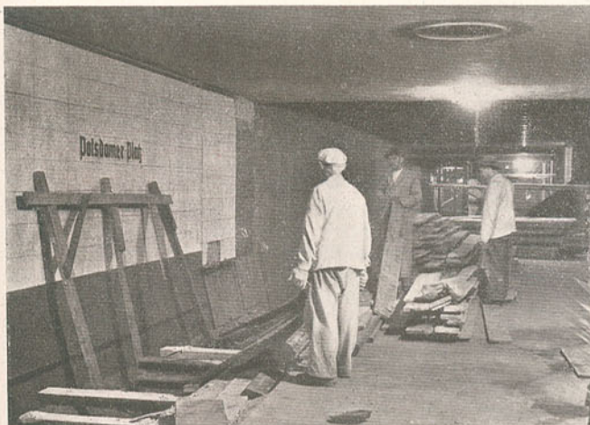
Debaixo da Potsdamer Platz de Berlim está sendo construída uma nova cidade a uma grande profundidade e que nada terá a recear dos aviões.
