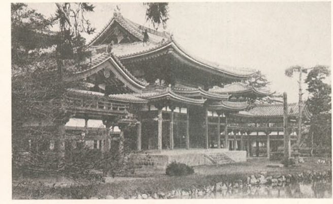
O célebre templo budista de Uji, perto de Kyoto (a colúmbra do Japão) e que é uma curiosidade arquitectónica
