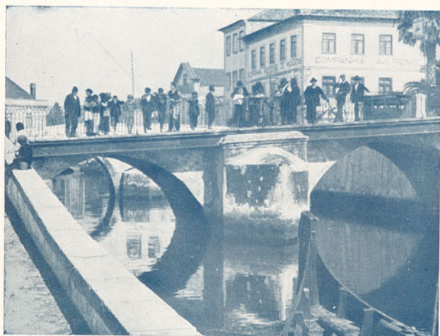
A ponte sobre a ria
