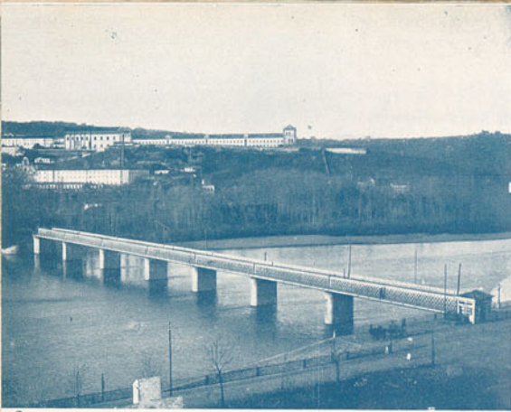
A Ponte da Portagem
