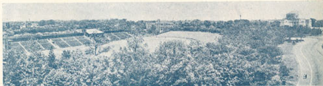
Os terrenos de Meiji Shrine, em Tóquio, onde está sendo construído o Estádio Olímpico de 1940
