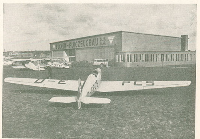
A nova avioneta «Student» que, com um motor de 50/60 H. P., gasta apenas 7 litros de combustível aos 100 quilómetros, atingindo uma velocidade de 175 à hora
