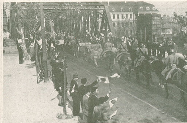
Tropas japonesas passando a ponte de Xangai por entre as aclamações de alguns chineses que prudentemente agitam bandeirinhas com as cores do Império do Sol Nascente
