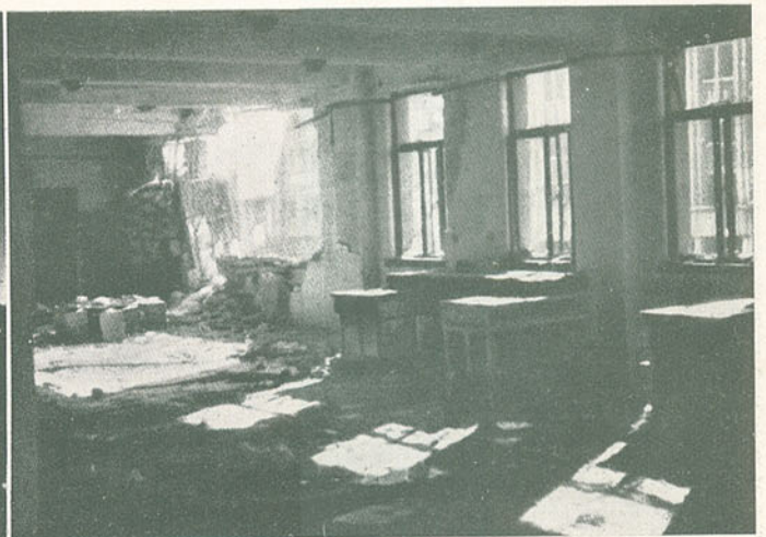
Os efeitos do bombardeamento dos japoneses no edifício da Estação do Norte em Chapei. As paredes foram rasgadas de alto a baixo, segurando-se o prédio por um capricho de equilíbrio que poupou os tectos e os pavimentos
