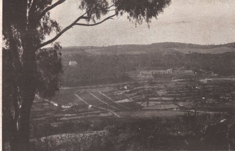
Vista geral das Caves da Raposeira
