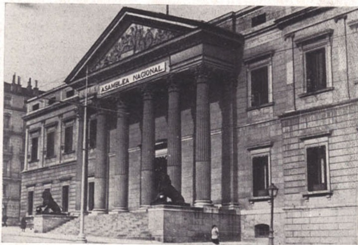
Fachada do edificio das c6rtes españolas
