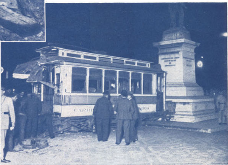
EM CIMA: O esta o em que ficou o automóvel colhido pelo comboio na Póvoa de Santa Iria. EM BAIXO, À ESQUERDA: Destroços do automóvel, espalhados ao longo da via férrea. À DIREITA: O carro eléctrico que chocou com a estátua do Duque da Terceira
