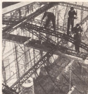
Nos estaleiros de Friedrichshafen reina uma actividade febril. Ultima-se a construção da armadura metálica dum novo dirigível do tipo Zeppelin que passa a ser designado simplesmente por L. Z. 129.
