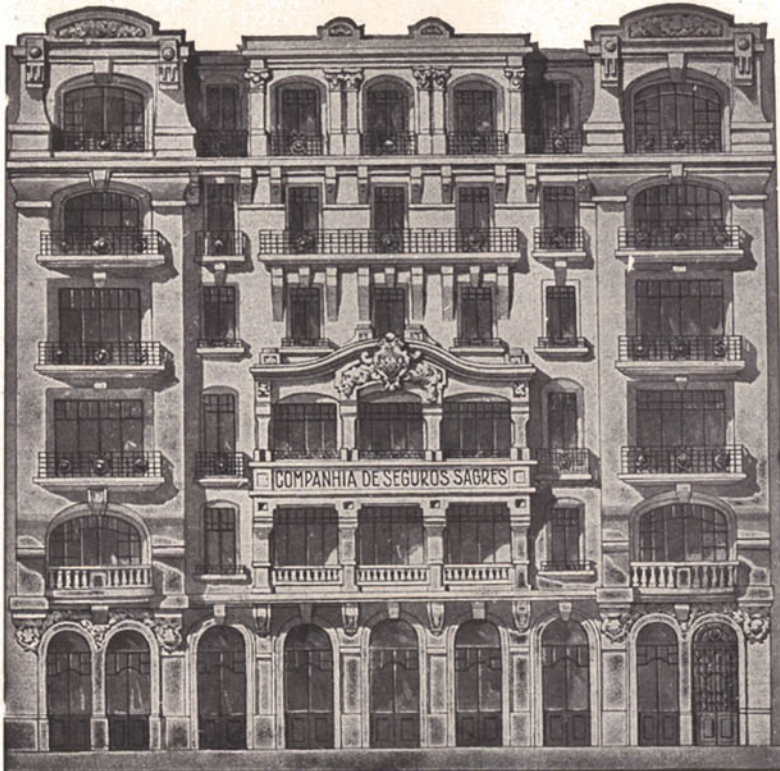
Aspecto do edificio na Rua do Ouro em Lisboa pertencente à Companhia, onde estão instalados os seus escritórios
