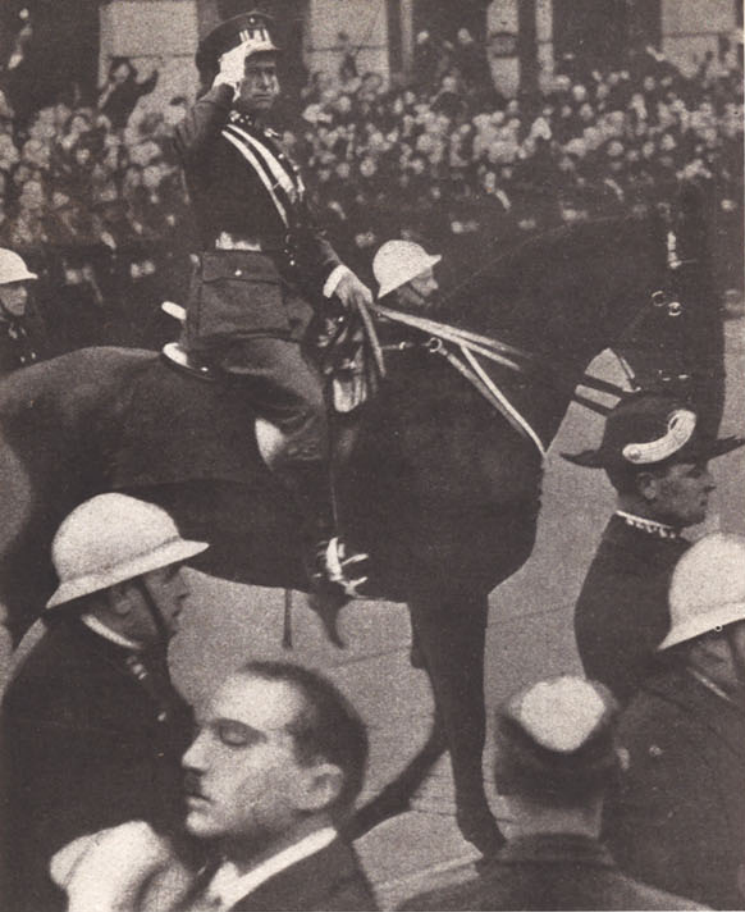
Leopoldo III fazendo a sua entrada real na cidade de Bruxelas entre alas compactas de povo
