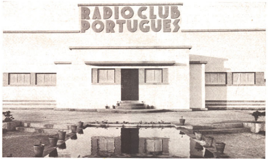
O novo edifício do «Rádio Club Português».
