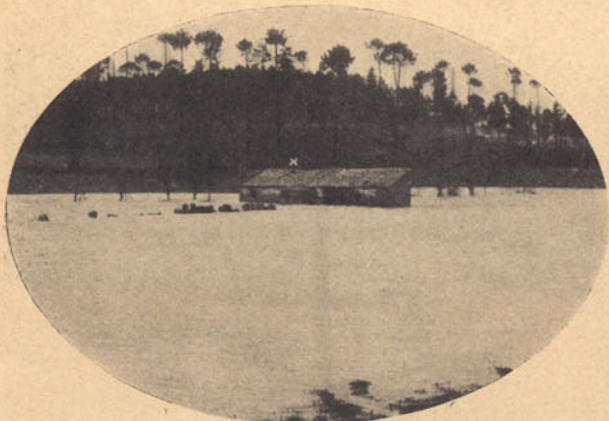
A CHEIA DO RIO LEXA — No lugar de Milheirós, concelho da Maia, as águas, durante a noite, inundaram os vales. — Um moimho submerso donde foram salvos uma mulher e quatro crianças pelo buraco que se vê no telhado (x)
