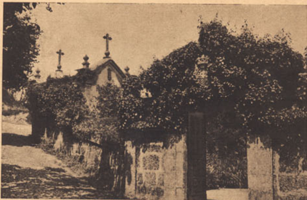
Casa dos condes de Paço Vieira (Portal de entrada)
