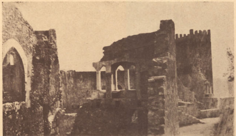
No Castelo de Leiria — Aspecto das muralhas
