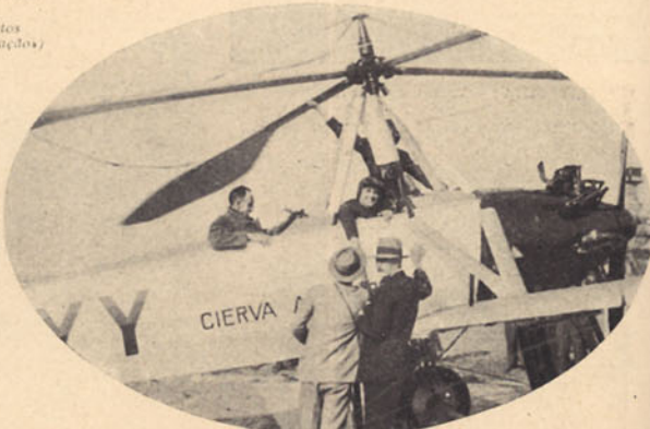
O aparelho denominado «Autogiro», invenção do engenheiro espanhol La Cierva, que parece destinado a revolucionar a aviação e que, tripulado pelo seu inventor, está realizando um circuito europeu. — (Foto H. Manuel)
