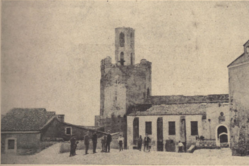
BADAJOS — Torre de Espantaperros
