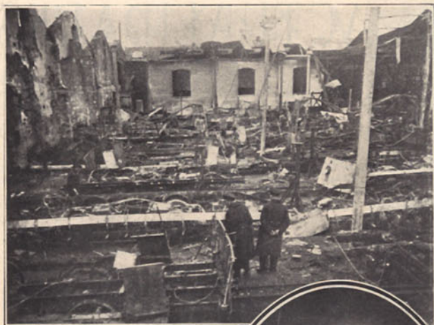
EM CIMA — Um incêndio pavoroso destruiu a remise dos eléctricos do Porto. Um aspecto do enorme edifício depois do rescaldo
