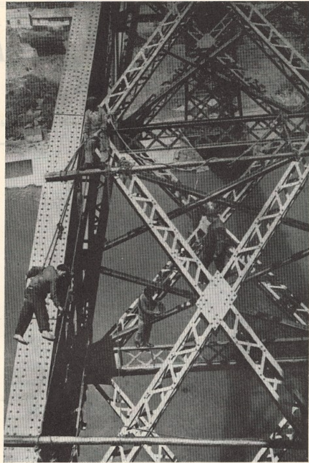
Pintura geral da Ponte D. Maria Pia, do lado de Gaia (Foto de Armando Ricco, inspector do Serviço de Obras Metálicas)
