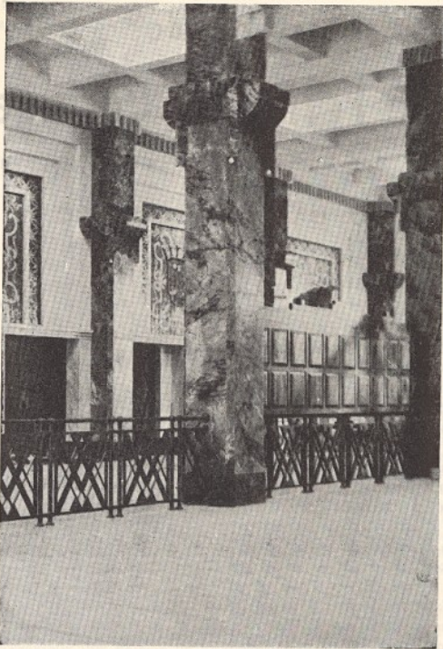
Um aspecto do interior da Estação do Terreiro do Paço
