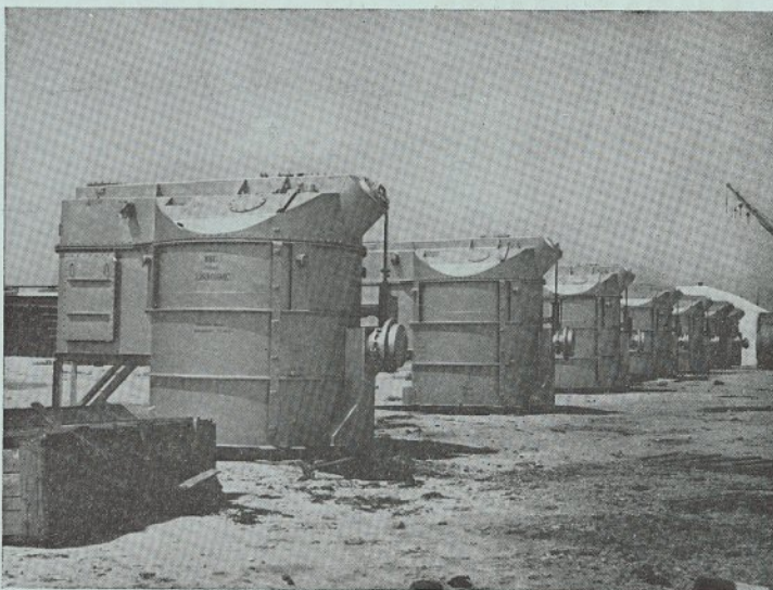
Auto-transformadores de 220/150 kv. destinados à subestação de PEREIROS da C. N. E. depois do desembarque no porto de Lisboa
