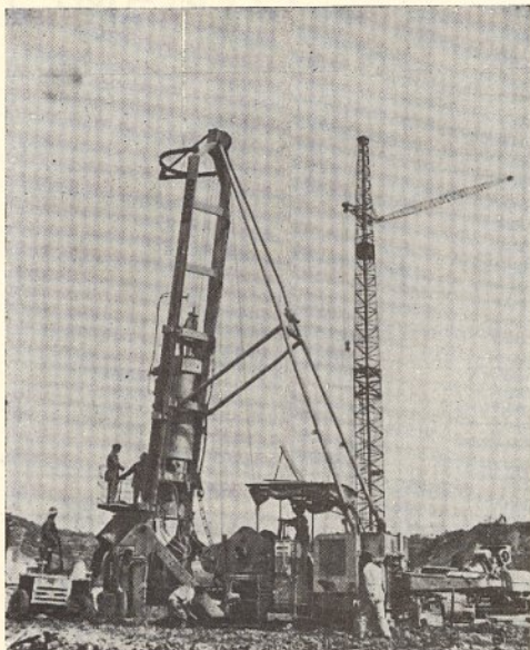
Máquina «BENOTO» executando estacas de 1 m. de diâmetro e 60 m. de comprimento nas fundações do viaduto de Sacavém, na auto-estrada do vale do Tejo
