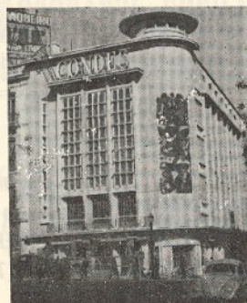
Fachada do Cinema Condes
