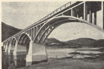
Ponte Barca d'Alva
