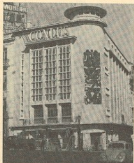
Fachada do Cinema Condes
