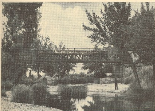
Ponte sobre o Caiola
