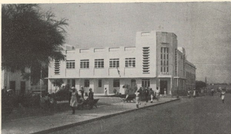
Um edifício moderno na Cidade da Praia ond. está instalado o Rádio Clube de Cabo Verde
