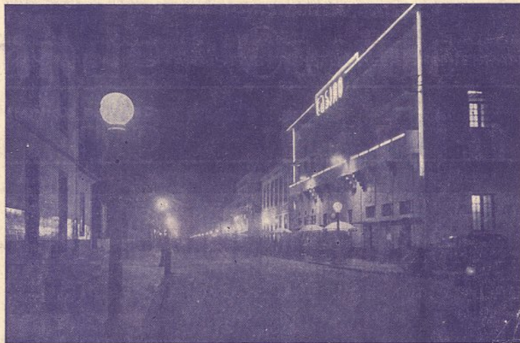
FACHADA DO CASINO À NOITE
