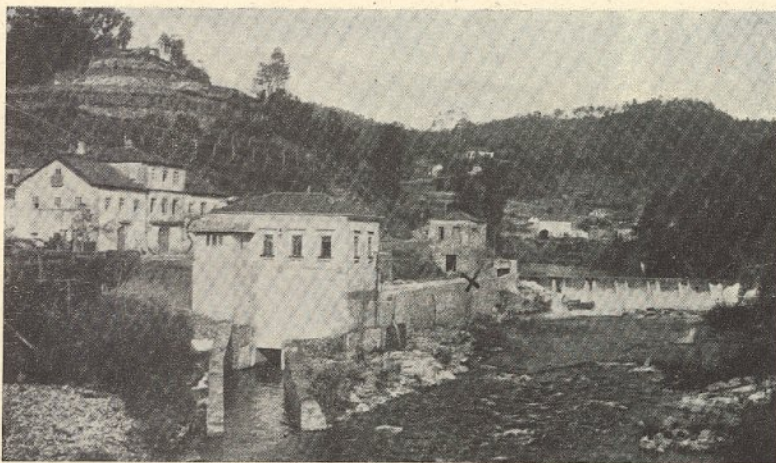
PESSEQUEIRO DO VOUGA — Vista parcial — Barragem do Vouga e Central Eléctrica
