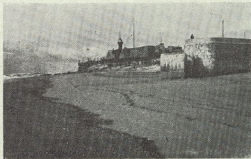
Assoreamento junto à barra do pôrto — lado norte — em frente do Forte de Santa Catarina
