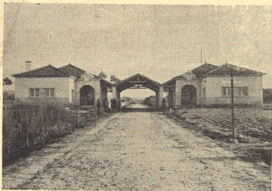
Pôsto fronteiriço de Vila Verde de Raia
