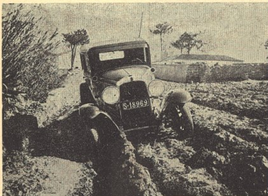
Estrada da Lourinhã ao Bombarral (Antes da reparação)
