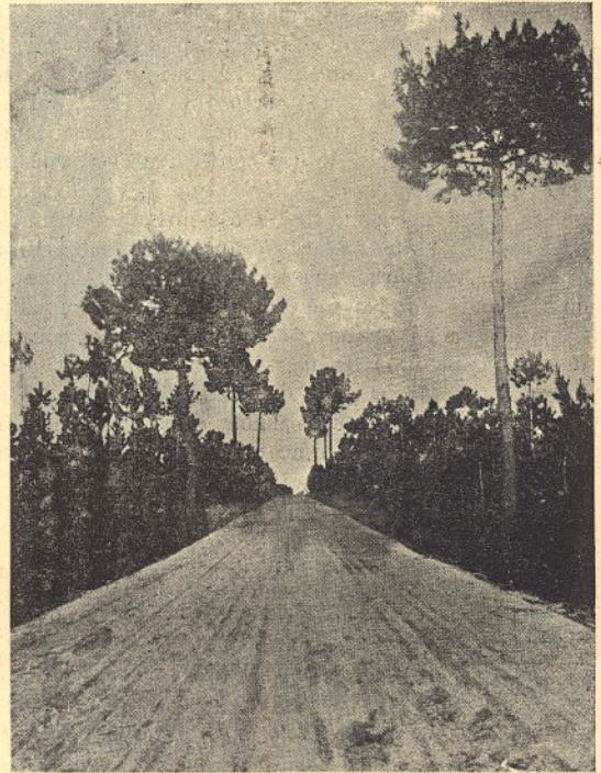
Ramal do Rio Judeu a Sesimbra (Depois da reparação)
