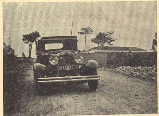
Estrada da Lourinhã ao Bombarral (Depois da reparação)
