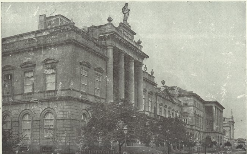
PORTO—Hospital da Misericórdia
