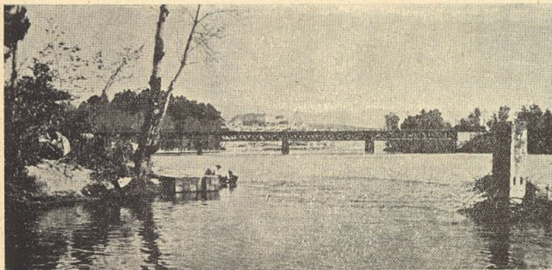
Ponte do caminho de ferro sobre o rio Mondego na linha do Norte. Ao fundo a cidade de Coimbra.
