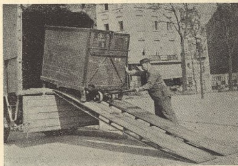
Carregamento de um «container» pequeno sobre camião
