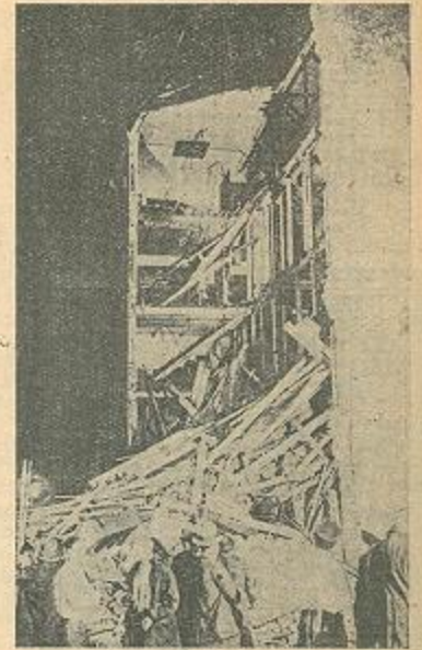
Na civilisadissima America tambem reventam bombas... das que deitam predios abaixo. Esta foi deitada como protesto contra a execução de Sacco e Vanzetti e derruiu o edificio do jornal da «Ku-Klux-Klan».
