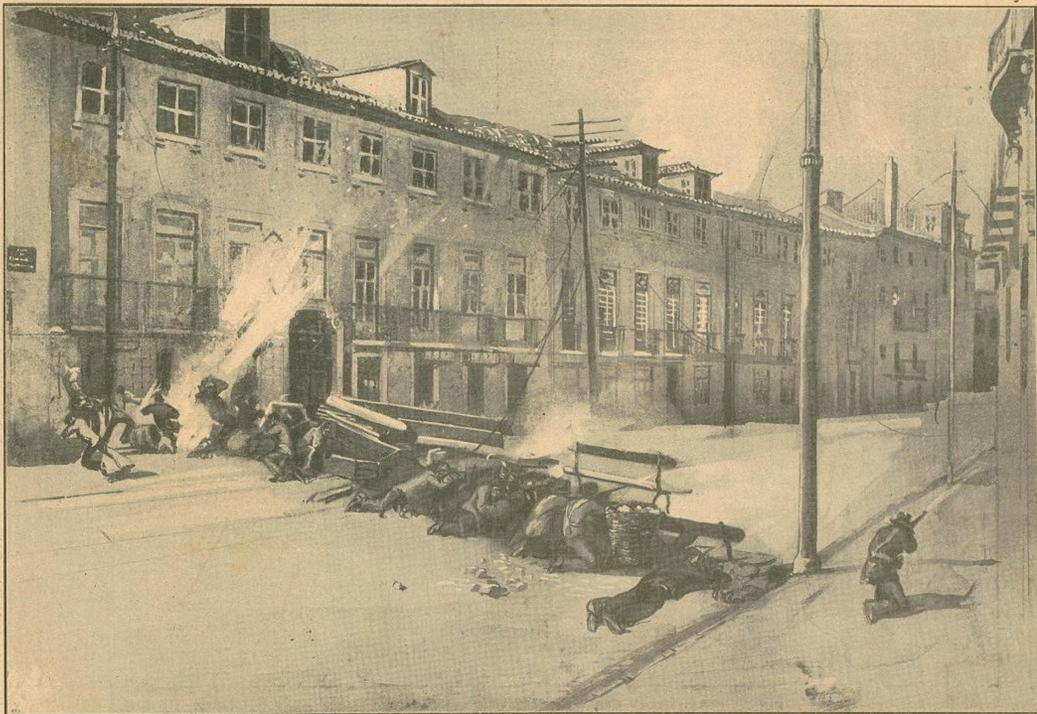
Na frente do Palacio Fontalva, os civis fizeram uma barricada que foi das mais difíceis de vencer. Granadas arruinaram o Palacio do Dr. Magalhães de Barros, que ocupa todo o fundo desta pagina, mas, até que as tropas fiéis tudo dominaram, fez-se intenso fogo do terrível reduto.
